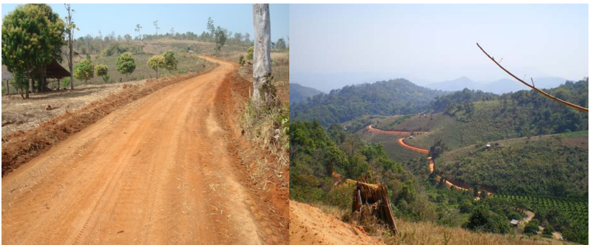
ภาพผนวกที่ 3 พื้นที่ได้รับการพัฒนาปัจจัยพื้นฐานด้วยการก่อสร้างเส้นทางลำเลียงไนโรนาในพื้นที่โครงการหลวง
