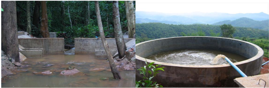
ภาพที่ 4.7 ฝายกั้นน้ำและบ่อพักน้ำ ขนาด 60 ลูกบาศก์เมตร
